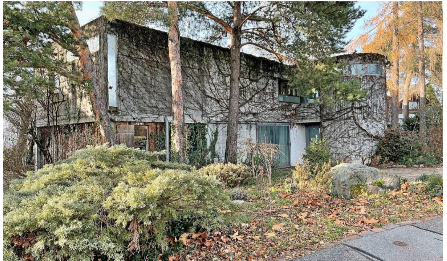
Strassenseitige Ansicht des Hauses. Ein Beispiel für gut gestalteten und konstruierten Beton ohne Bauschäden. Foto: Jürg Schweizer
